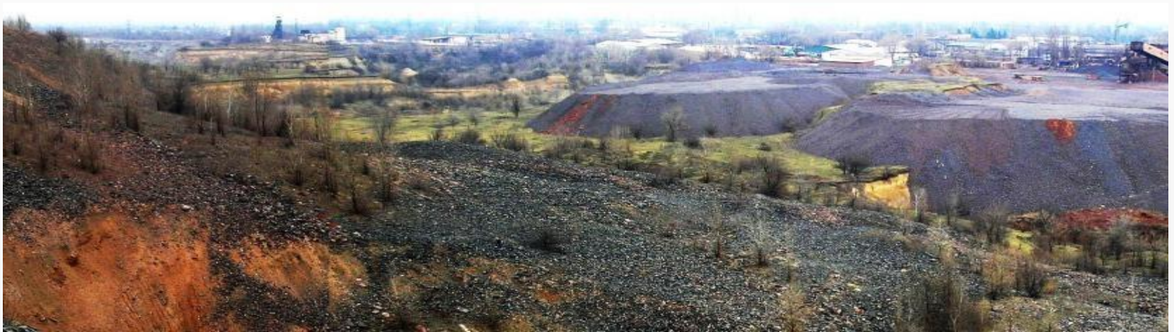
Провальна зона шахти Ювілейна ПАТ «Суша Балка»
